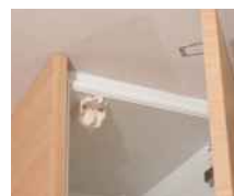
廊下収納、各居室のシステム収納に収納物の飛び出しを防ぐ 耐震ラッチ
